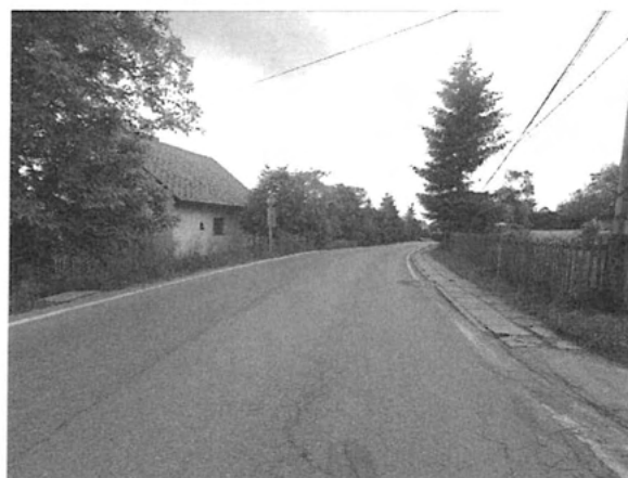
Mozaikové trhliny, podélná trhlina, výprávy
